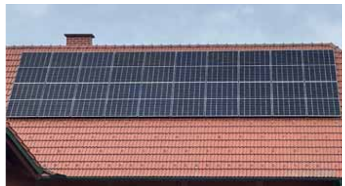
Der Klassiker ist immer noch die Montage an der Dachschräge.
