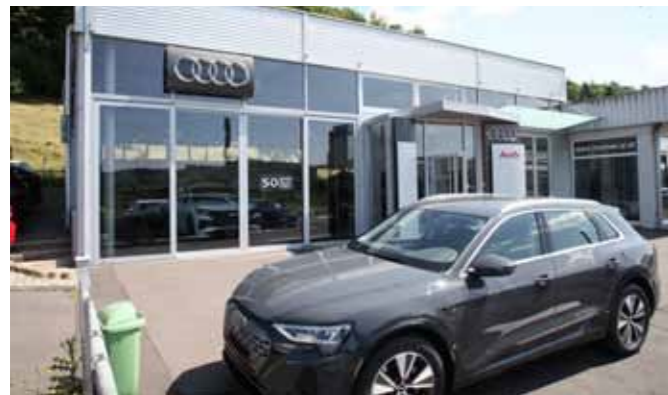
Der Audi-Schau- und Verkaufsraum wurde 2004 errichtet.
